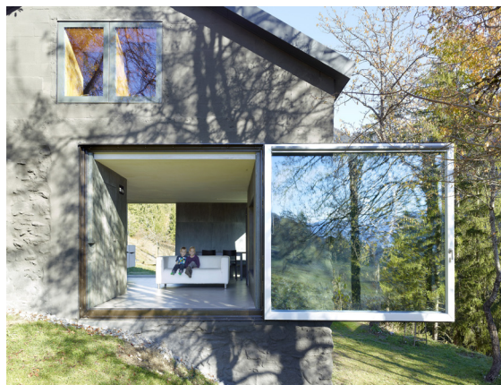
Transformation Savioz à la Giète-Délé (VS), 2011-3, Savioz Fabrizio Architectes. Nominiert DRA3 2014
